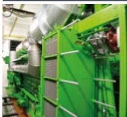
Die in den Werken der BMW Group<sup>1</sup> in Regensburg und Leipzig installierten Kraft-Wärme-Kopplungsanlagen können vor Ort Strom erzeugen und die Abwärme der Motoren für die Produktionsprozesse in den Werken nutzen. Für die Winterheizung wird die Abwärme der Motoren mit der Wärme der vorhandenen Heizkessel kombiniert.
