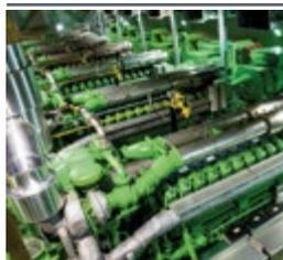
Mit insgesamt sechs Jenbacher J624 Motoren, die mit Pipelinegas betrieben werden, erreicht das Kraftwerk Hakha in Daejeon, eine elektrische Gesamtleistung von 25.182 kW sowie einen Gesamtwirkungsgrad von 87%. Mit der Installation der Jenbacher Motoren wurde das Kraftwerk zu einer der größten Gasmotorenanlagen in Südkorea.
