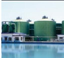
Die Biogasanlage Shandong Minhe in Penglai City wird mit drei im Jahr 2009 installierten J320 Motoren und einem im Jahr 2018 installierten J620 Motor betrieben. Die Anlage liefert eine elektrische Leistung von 6,2 MW und arbeitet mit Biogas, das durch die Hühnermist- und Gülleschlammvergärung erzeugt wird.
