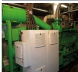
Un seul moteur J208 à la centrale de production combinée de chaleur et d'électricité (PCCE) de Schlitters transforme chaque année près de 12 000 tonnes de restes d'aliments et de déchets biodégradables en électricité et chaleur. Les déchets biodégradables résiduels digérés sont alors comprimés en compost ou transformés en purin afin de fertiliser les terrains agricoles de la région.
