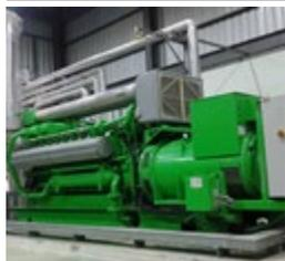
Axée sur quatre moteurs Jenbacher J320 fonctionnant au biogaz, la centrale produit de l'électricité à partir des eaux usées et des déchets solides issus de la transformation des racines de manioc brut. La centrale électrique au biogaz a un rendement de 4,27 MV, plus que suffisant pour couvrir l'ensemble des besoins en électricité de l'usine de transformation. L'installation peut réaliser des profits supplémentaires en revendant le surplus d'électricité au réseau local.
