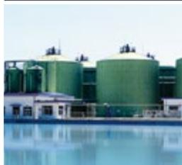
Le projet de production d'électricité au biogaz de la ferme utilise le lisier de poulet et la fermentation des eaux usées pour produire du biogaz. Mise en service en 2009, l'installation est alimentée par trois moteurs au biogaz Jenbacher J320, et un moteur J620 a été ajouté en 2018.
