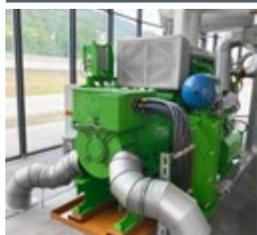
Dans l'installation de traitement des eaux usées de Fritzens, deux moteurs alimentés au gaz d'égout Jenbacher J312, d'une capacité totale de plus de 1,27 MW d'électricité, couvrent l'ensemble des besoins annuels en électricité. La chaleur produite par les moteurs est utilisée pour traiter les déchets alimentaires, produisant ainsi l'énergie supplémentaire utile au traitement des déchets.
