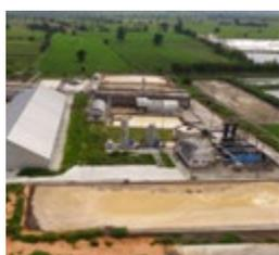
Cinq moteurs au biogaz Jenbacher J420 produisent bien plus d'électricité que nécessaire pour alimenter l'usine de production d'amidon de tapioca de Chok Yuen Yong Industry Co., LTD. Le surplus d'électricité produit par les moteurs – près de 1 000 kW – alimente le réseau public tout en réduisant les coûts d'électricité de l'usine.
