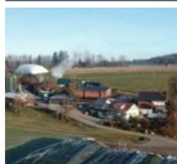
随着颜巴赫 J420 发动机的安装,以及对大型缓冲储罐和储气罐的投资,德国 Heslerhof 农场的生物沼气厂被改造成了一个可循环储电厂。它的运营非常灵活,且适应电力市场的变化。该农场实现了电力自给自足,剩余电力参考市场价格,以有吸引力的上网电价馈入电网。
