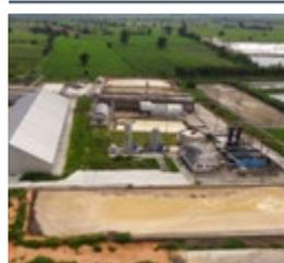
五台颜巴赫 J420 生物沼气发动机产生的电力足以供应 Chok Yuen Yong Industry Co., LTD 的木薯淀粉厂。发动机产生的剩余电力 (约 1000 kW) 供应给公共电网,进一步降低了设施的电力成本。
