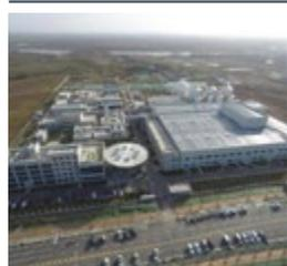
合肥小庙有机资源处理中心项目的处理设施占地近 6.7 万平方米,有机废物在其中经过预处理,然后通过厌氧发酵转化为生物沼气。两台颜巴赫 J420 生物沼气发动机组为该设施供电,同时也为当地电网供电。
