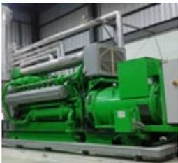
이 공장은 바이오가스로 작동하는 엔바허 J320 엔진 4대를 중심으로 카사바 뿌리 가공 과정에서 발생하는 폐수 및 고품 폐기물을 사용하여 전기를 생산합니다. 바이오가스 발전소의 4.27 MW의 전력을 생산하며 가공 공장의 모든 전력 수요를 공급하기에 충분합니다. 이 시설은 남은 전력을 지역 전력망에 판매하여 추가 수익을 올릴 수 있습니다.
