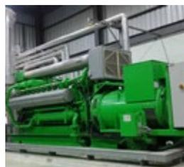
イェンバッハJ320バイオガス燃料エンジン4基を中心に、キャッサバの根の加工から発生する廃水と固形廃棄物を利用して発電を行っています。バイオガス発電所の出力は4.27 MWで、これは処理プラントの全電力を供給するのに十分な量です。この施設は、余剰電力を地域の送電網に売り戻すことによって、余分の利益を得ることができています。
