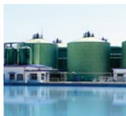
同農場のバイオガス発電プロジェクトでは、鶏糞と下水の発酵を利用してバイオガスを製造しています。2009年に稼働が始まったこの施設では、3基のイェンバッハJ320バイオガス燃料エンジンによって電力が供給され、2018年にはJ620バイオガス燃料エンジンが追加されました。
