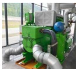
Fritzens廃水処理プラントでは、2基のイェンバッハJ312下水燃料エンジンが、総容量1.27 MW以上の発電を行い、プラントの年間電力需要全体をまかっています。エンジンから発生する熱は、食品廃棄物を処理するために利用され、廃棄物処理のためのさらなるエネルギーを生み出しています。
