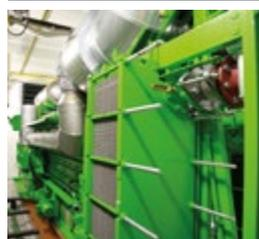
BMWグループ<sup>1</sup>のレーゲンスブルクとライプツィヒの工場に設置されたコージェネレーションプラントは、オンサイト発電に加え、エンジンの廃熱を回収および利用して工場の生産プロセスをサポートしています。冬の暖房は、エンジンの廃熱と既存のボイラーの熱を組み合わせ利用しています。
