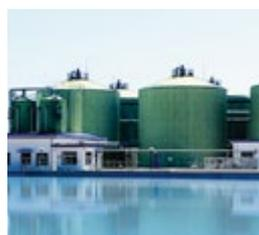
Shandong Minheバイオガス発電システムは、2009年に設置された3基のJ320エンジンと2018年に設置された1基のJ620エンジンでまかなわれています。このプラントは、鶏糞と下水の発酵により生産されるバイオガスを利用して、6.2 MWの電気出力を達成しています。
