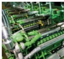
パイプラインガスで稼働するイエンバッハJ624エンジン6基を搭載したテジョンのHakhaサイトは、25,182 kWの電気出力と87%の総合効率を実現しています。これらのイエンバッハエンジンの導入により、このサイトは韓国最大級のガスエンジンプラントとなりました。
