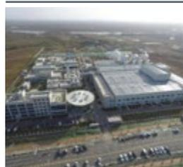
Im „Hefei Xiaomiao Organic Waste Treatment Center Project“ werden organische Abfälle vorbehandelt und mittels anaerobe Vergärung in einer knapp 67.000 Quadratmeter großen Anlage in Biogas umgewandelt. Zwei biogasbetriebene Jenbacher J420 Gen-Sets versorgen nicht nur die Anlage mit elektrischer Energie, sondern speisen auch Strom in das örtliche Stromnetz ein.
