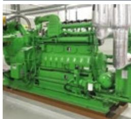
マウルブルグでは、合計1145 kWのイエンバッハ発電機セットが2基、Endress+Hauser SE+Co. KG プラントに供給されています。2014年に845 kWのイエンバッハ発電機セットの運用が開始された後、2020年にイエンバッハ J208 発電機セットが設置されました。イエンバッハ CHP ソリューションは、会社の施設に電力と熱を確実に供給します。
