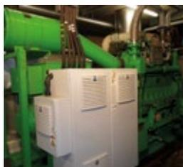
シュリッターズにある熱電併給 (CHP) ステーションに設置されている J208エンジンは、1基で年間約12,000トンの食品残渣やバイオ廃棄物を電気と熱に変換しています。消化されたバイオ廃棄物は、圧縮されて堆肥になるか、液肥になって地域の農地の肥料として使用されます。
