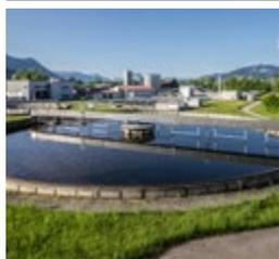
Abwasserverband Obere Iller 廃水処理プラントでは、毎年、オーバーアルゴイ地区の11の自治体から排出される1,370万立法メートルの廃水を浄化しています。2016年からは高効率のイエンバッハ J208エンジンを採用し、電力需要の65%、熱需要の95%をカバーしています。
