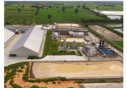
イエンバッハJ420バイオガス燃料エンジン5基は、Chok Yuen Yong Industry Co., LTDのタピオカでんぷん工場に供給するのに十分な電力を生産しています。エンジンで発電した余剰電力 (約1,000kW) は、公共の送電網に供給され、施設の電力コストをさらに低減しています。
