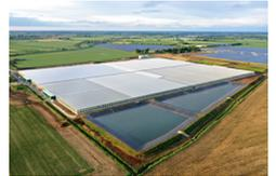
AGRのFenland Glasshouse & Energy Centerには、電気を供給する高効率のイエンバッハエンジン3基を備えた熱電併給 (CHP) プラントと、植物の成長を助けるために回収されたCO<sub>2</sub>を供給する排気冷却システムがあります。さらに、革新的な33 MWthヒートポンプシステムは、この施設に再生可能な温水熱源を提供します。
