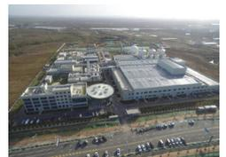
Hefei Xiaomiao有機廃棄物処理センター事業では、約67,000平方メートルの施設で有機廃棄物を前処理し、嫌気性消化によりバイオガスに変換します。2基のイエンバッハJ420バイオガス燃料発電機セットが、同施設に電力を供給し、地域の送電網にも電力を供給しています。
