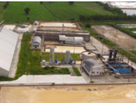
Cinco motores movidos a biogás Jenbacher J420 produzem energia elétrica mais que suficiente para abastecer a fábrica de amido de tapioca Chok Yuen Yong Industry Co., LTD. A eletricidade em excesso produzida pelos motores — cerca de 1.000 kW — é fornecida à rede pública, para reduzir ainda mais os custos de energia da instalação.
