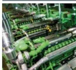
大田市哈卡区共有 6 台使用管道燃气的颜巴赫 J624 发动机,总电力输出达 25,182 kW,总效率达 87%。安装这些颜巴赫发动机后,该工厂成为韩国最大的燃气发动机工厂之一。
