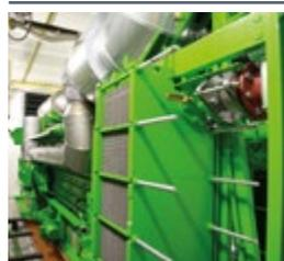
宝马集团<sup>1</sup>雷根斯堡工厂和莱比锡工厂安装的热电联供厂可现场发电,并收集发动机余热支持工厂的生产过程。冬季通过发动机余热结合现有锅炉热量供热。
