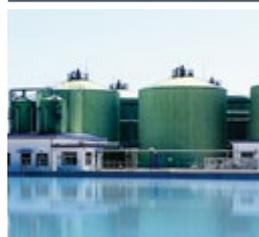
蓬莱市的山东民和生物沼气发电系统由 2009 年安装的三台 J320 发动机和 2018 年安装的一台 J620 发动机驱动。该工厂利用鸡粪和污水发酵产生的生物沼气实现了 6.2 MW 的电力输出。
