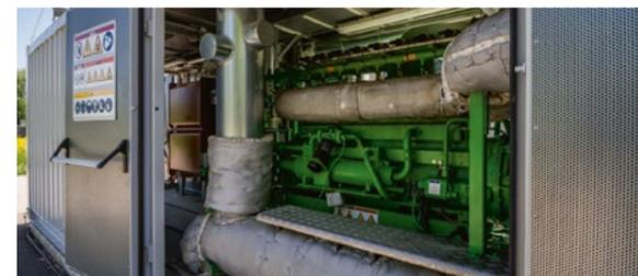
»采用INNIO创新的颜巴赫技术使用污水沼气作为一种可再生能源为污水处理厂提供主要能源供应, 帮助客户在能源转型中发挥重要作用。«
